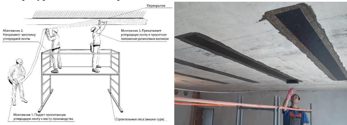
6. Для повышения сцепления элементов усиления с последующими покрытиями (огнезащита, штукатурка и проч.), рекомендуется по «свежему» слою смонтированной углеродной ленты нанести слой кварцевого песка крупностью 0,5-2мм.
