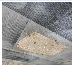
8. Для повышения сцепления элементов усиления с последующими покрытиями (огнезащита, штукатурка и проч.), рекомендуется по «свежему» слою смонтированной углеродной ленты нанести слой кварцевого песка крупностью 1,0-2мм.
