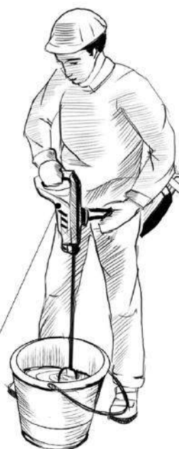
Перемешивание низкооборотистой дрелью с ворошителем
