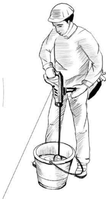
Перемешивание низкооборотистой дрелью с ворошителем
