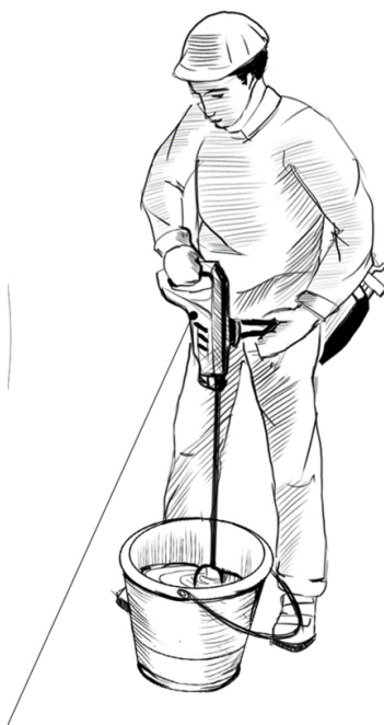
Перемешивание низкооборотистой дрелью с ворошителем
